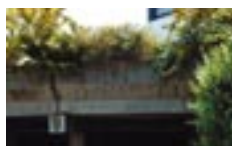
Tiefgarage mit mind. 30 cm Bodenschicht
