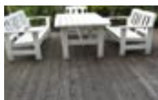
Terrasse, nicht an die Kanalisation angeschlossen
