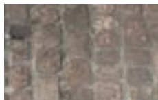
Steinbelag mit Fugenverguss
